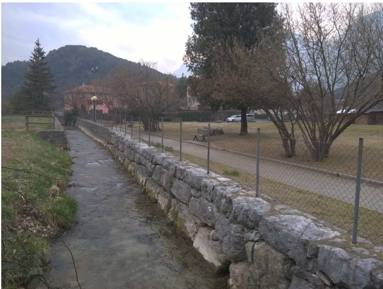
La roggia di Padergnone a monte del ponte ed il parco esistente in sinistra orografica
